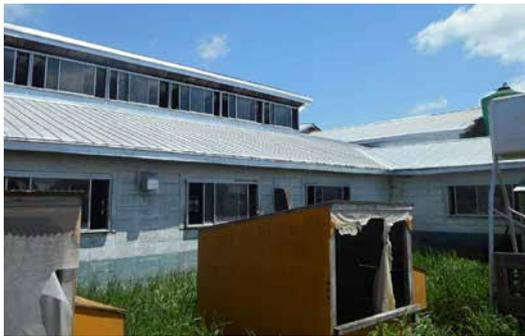
写真① 牛舎屋根の銀塗装
