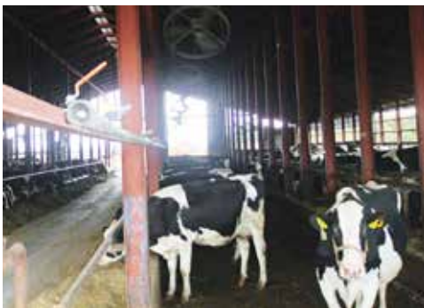
写真1 フリーストールにおけるミスト状噴霧配水管
