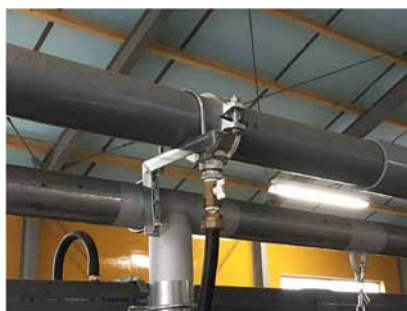
写真④ ウォーターカップの配管を太くする
