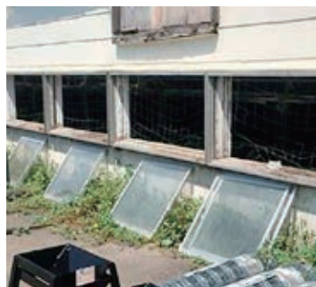
写真1 窓を取り外した牛舎
