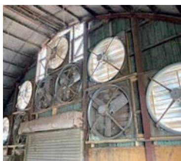
写真3 壁の換気扇の増設
