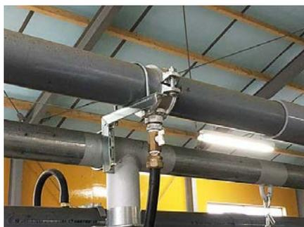
写真2 吐水量確保のために配管を太くした事例
