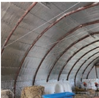
写真2 D型ハウス内壁に遮熱シートを施工した事例
