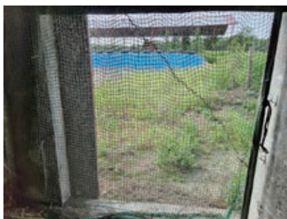
写真2 既存の動物侵入防止ネットの上に昆虫駆除のネットを設置した様子
